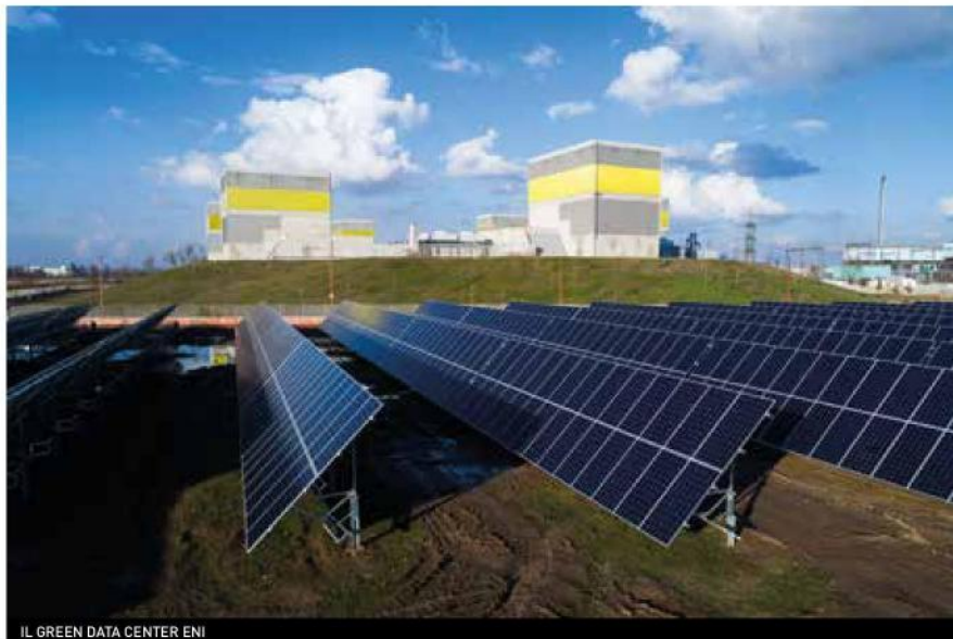
IL GREEN DATA CENTER ENI
